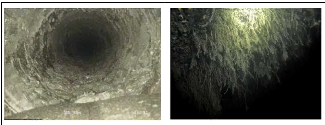
شکل ۵: تشکیل رسوبات زیستی در ابتدای خطوط آبگیری و چسبیدن جلبک‌ها روی لوله‌های آبگیری (غواصی اردیبهشت ۱۴۰۴)
