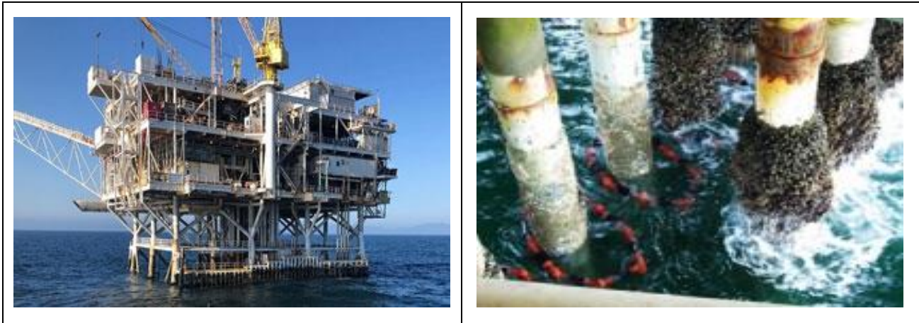
شکل ۸: نمایی از بیوفولینگ در پایه سکوی دریایی
